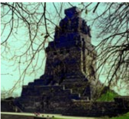
Völkerschlachtdenkmal und Höhenüberwachungsnetz im Umgang unter der Krypta
