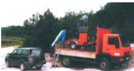
Drucksondieranlage in der Kombination mit automatischer Messstation im Einsatz
