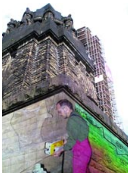
Messung am Völkerschlachtdenkmal
