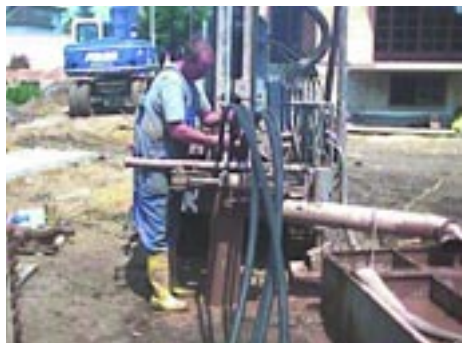
Erdsondenanlage in Tollwitz Spülbohrung, 4 Sonden 80 m
