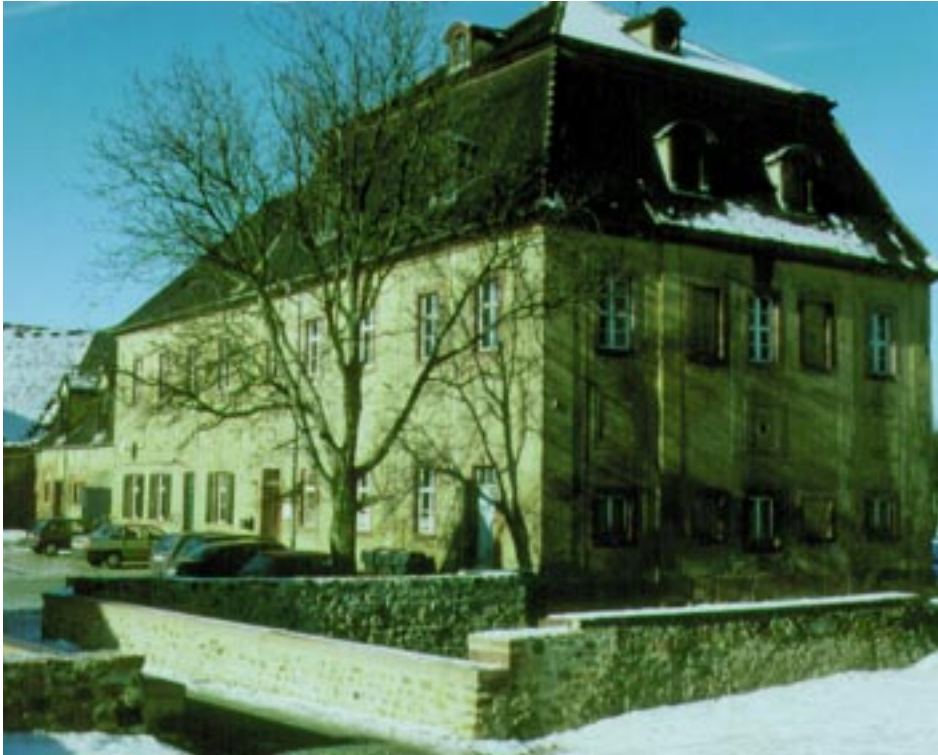
Das Umweltzentrum der HWK zu Leipzig, das ehemalige Herrenhaus des Schlosses Trebsen
