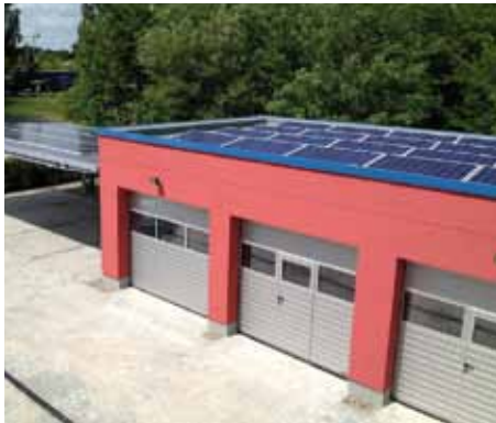
Carportanlage mit Ladesäule und PV-Anlage
