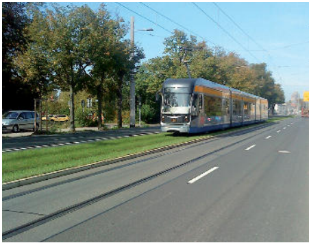
Überfahrt einer Straßenbahn auf der Prager Straße, nach erfolgter Sanierung
