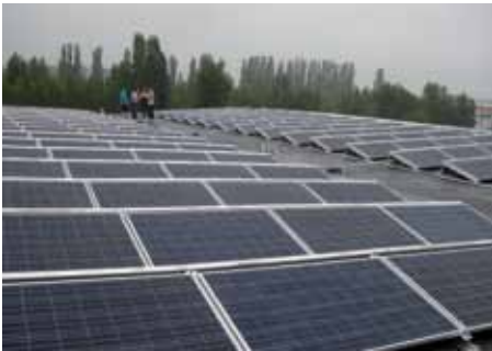
Photovoltaikanlage zur Eigenstromerzeugung auf dem Dach eines mittelständigen Unternehmens
