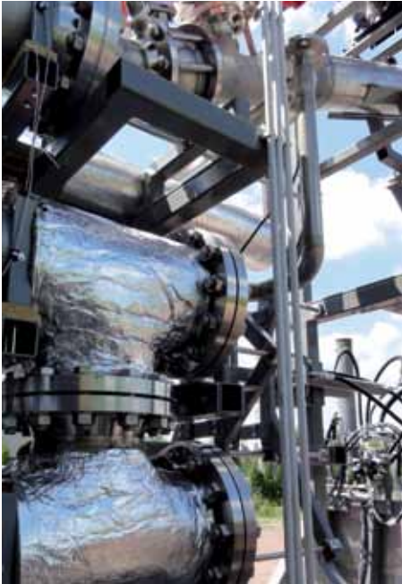
Bioabfall, Gärreste oder Klärschlamm können in einem Druckreaktor zu Biokohle umgewandelt werden.
