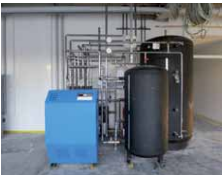
Adsorptionskälteanlage eCoo mit Pufferspeicher
