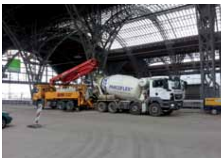
Einer unserer Fahrmischer beim Entladen des Parcoflex®-Flüssigbodens in die Pumpe zur Weiterförderung durch ca. 300 m Rohr- und Schlauchleitung bis zur Verfüllstelle.
