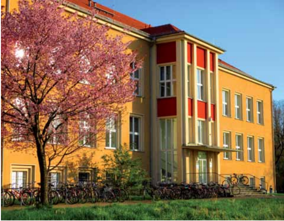
Gebäude des Instituts für Biologie (Foto: Andrea Fanesi)
